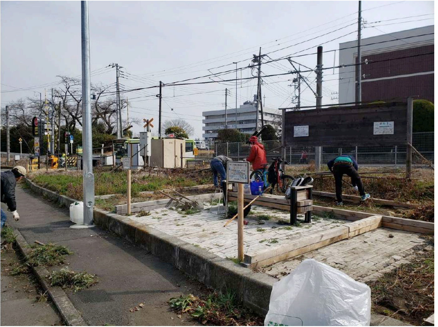
整備作業風景
