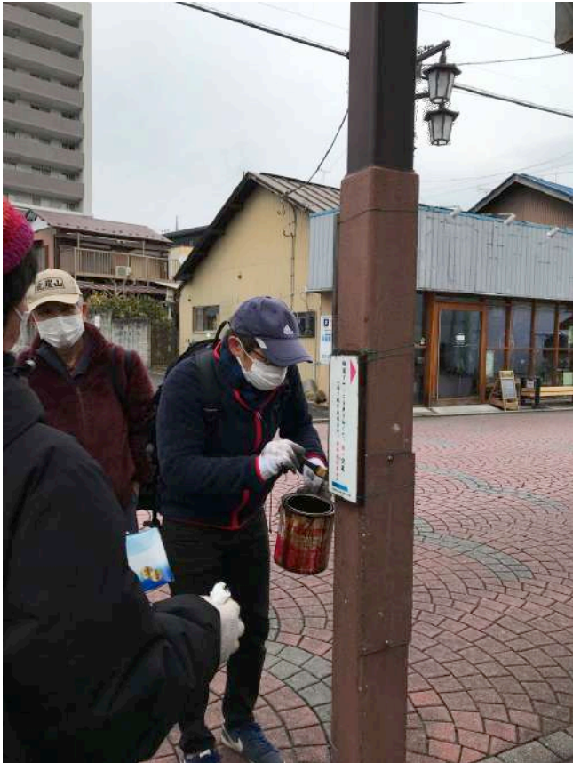
すでに設置されている看板にも防腐剤を追加で塗布している
